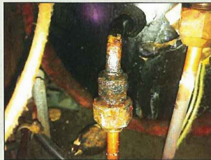
(写真)漏えい箇所
