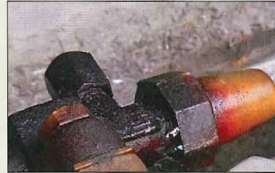
(写真)漏れ箇所
