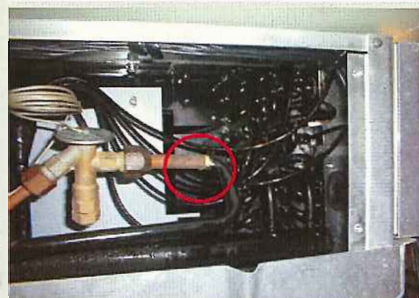
(写真)漏れ箇所
