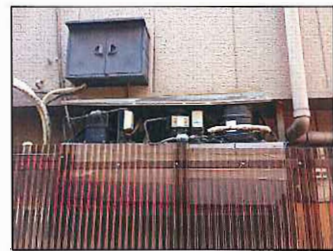
雨ざらしの室外機
