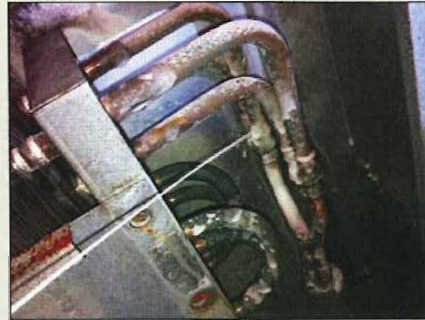
(写真) 漏れ箇所
