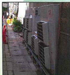
倒れそうな室外機
