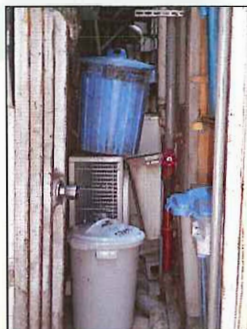
吹き出し口が塞がった室外機
