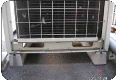
室外機のキズ
