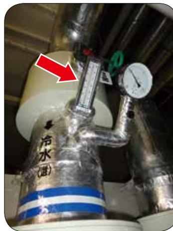
写真-D 冷水入口温度
