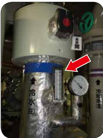
写真-C 冷水出口温度
