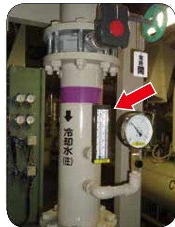
写真-E 冷却水入口温度
