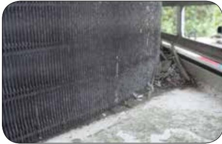
熱交換器下部の腐食
